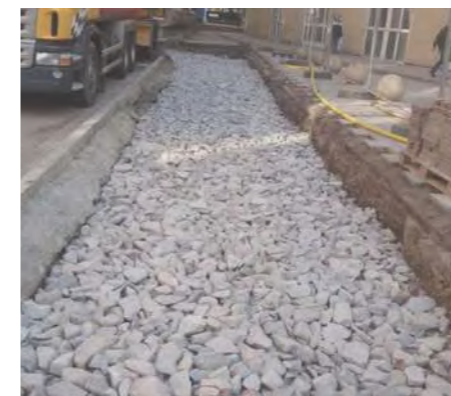
3. couche structurante 90/150 mm
