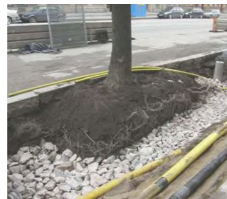
1. préservation des arbres existants
