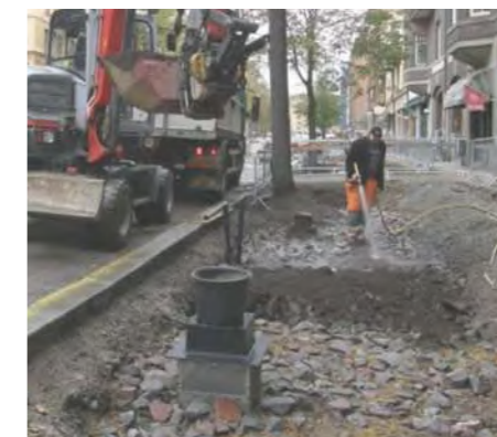
5. incorporation de terre végétale
